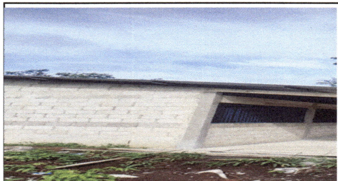
FINALIZACION DE COLOCACION DE CORREDOR
