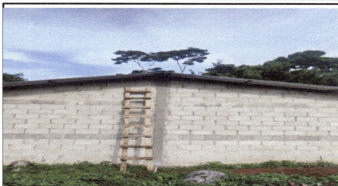
Foto 2: FINALIZACION DE INSTALACION TE TECHO
