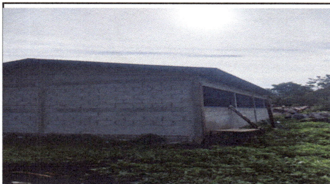
FINALIZACION DE COLOCACION DE BALCONES
