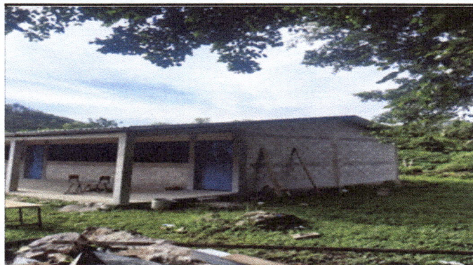
Foto1: FINALIZACION DE INSTALACION DE PUERTAS.
